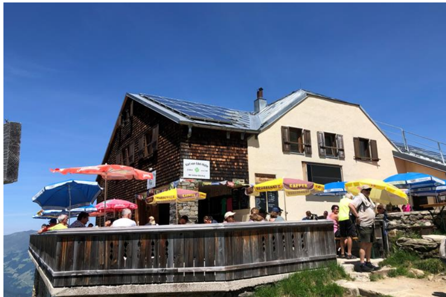
Karl-von-Edel-Hütte mit neuer PV-Anlage
