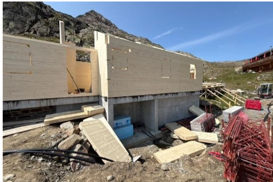
Vernagthütte Bauphase lawinensicheres Winterlager
